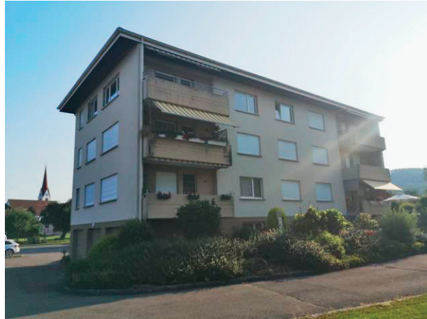
Bestehende Balkone an der Südfassade
