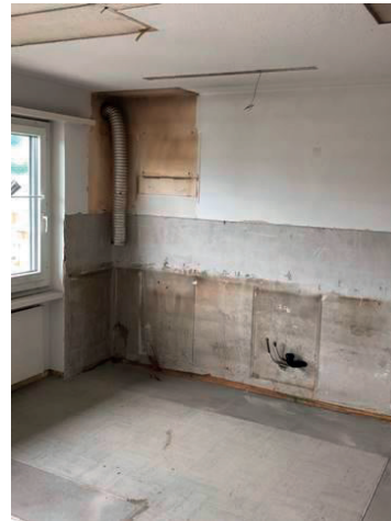
Bildlegende: Sämtliches Mobiliar sowie alle Apparaturen der «alten Küche» sind demontiert und abgebrochen
